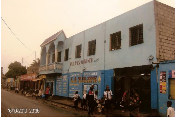
Muren moeten nog worden afgewerkt
