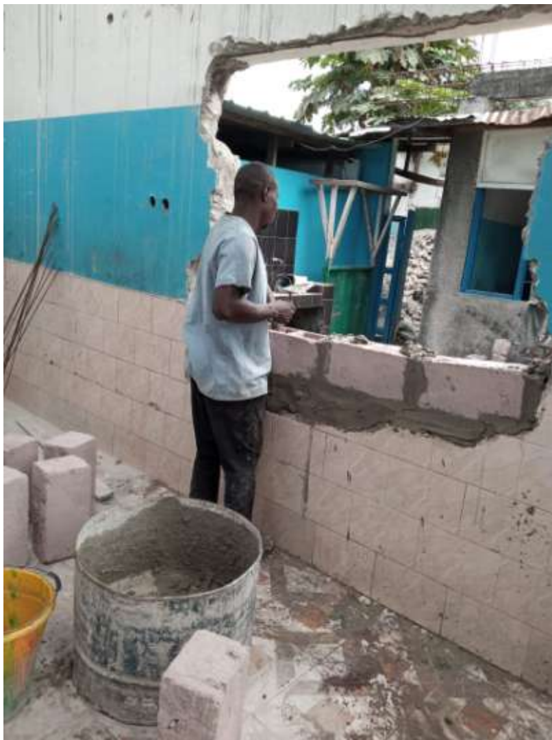
Bouwvakker van Arambe repareert schoolgebouw La Tulipe
